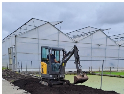
Bloemenstrook in aanleg bij Griffioen Wassenaar
